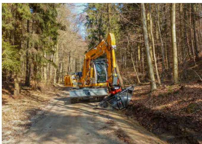
Abb. 2: Der Grabenbagger beseitigt Grasnarben und anderen Bewuchs und formt den Graben neu aus.
