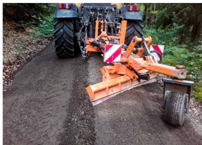
Abb. 3: R2005-Geräte haben sich für die laufende Wegepflege gut bewährt und lassen sich problemlos an einen Schlepper anbauen.
